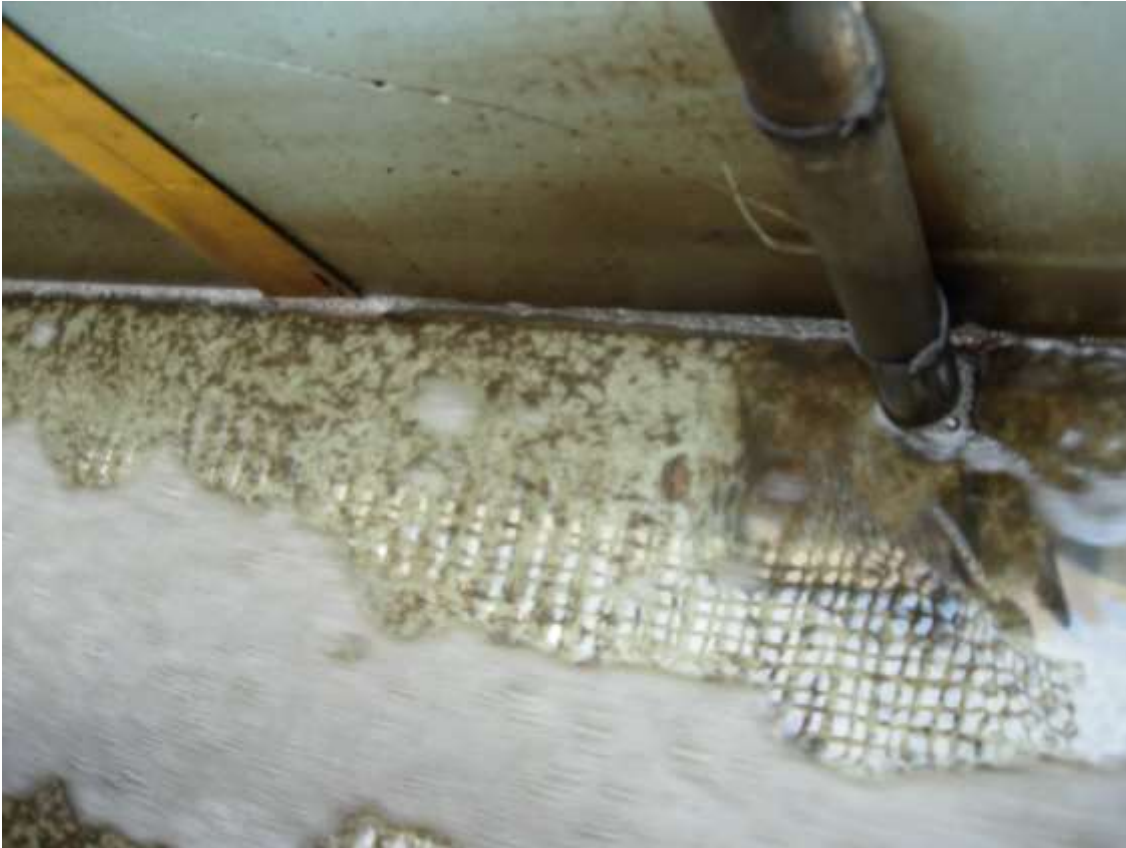
Lame déversante du bypass physico et de la surverse bassin d'orage
